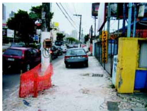
Calçadas inseguras sem placas de orientação
